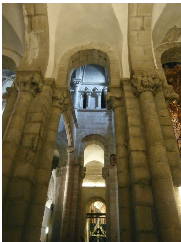
Fig. 4. Detalle del lado sur del crucero
