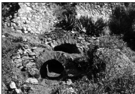
Figura 2. Boca de horno. Huancavelica.
