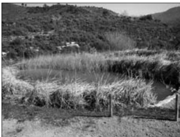
Figura 3: Depuradora del Mas de Noguera. La depuració d'aigües residuals funciona de forma natural amb decantació i absorció de les mates de joncs. L'aigua depurada rega els camps a l'estiu i la palla calenta els animals.
