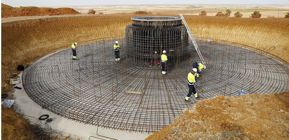
Figura 3. Cimentación de un aerogenerador. Fotografía: Antonio Quintero. El Norte de Castilla. https://www.elnortedecastilla.es/palencia/paredes-nava-suma-20190824205335-nt.html?ref=https%3A%2F%2Fwww.google.com%2F
