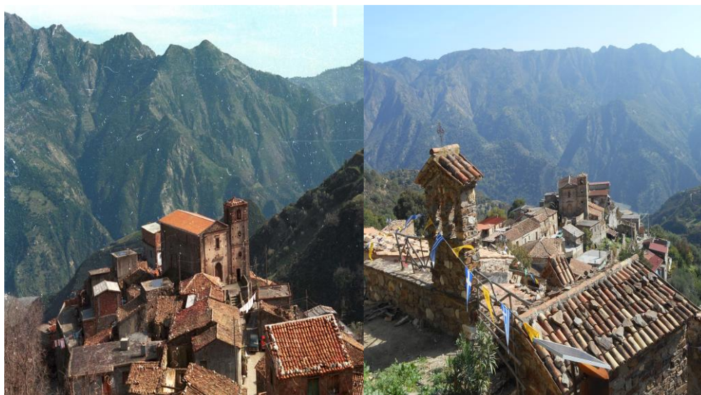
Γκαλιτσιανό 1984. Φωτ. Σωτήρη Χρηστάκη
